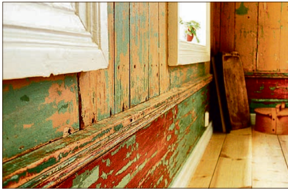
FARGETRAPP: Kjøkkenpanelet på Roksvold er i dag nesten som en stor fargetrapp. Vi ser alle fargene fra det ble malt første gang og frem til i dag.
