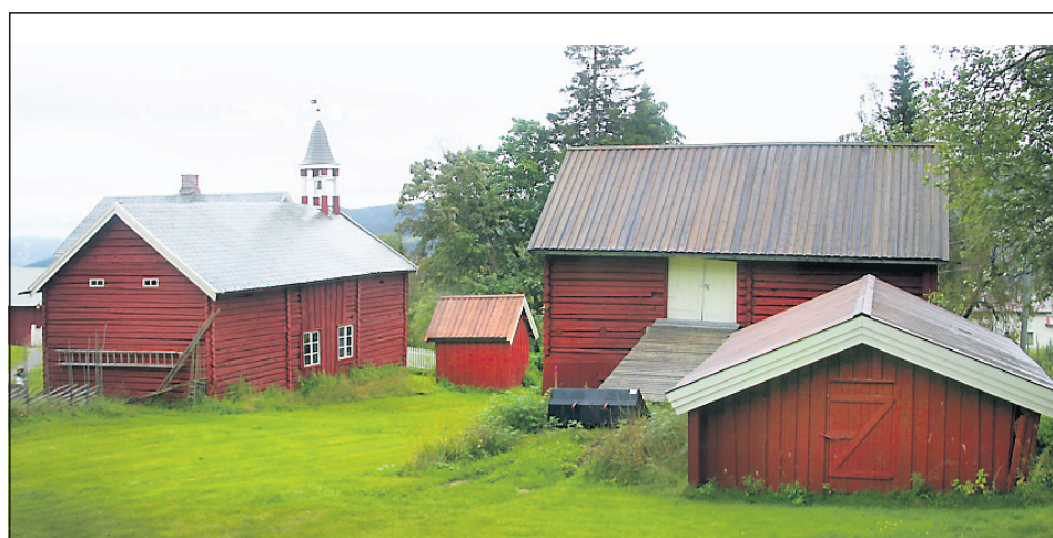
BEISET TRETAK: På flere av bygningene er det lagt tretak, sofistikert beiset for å passe sammen med skifertakene på tunet.
