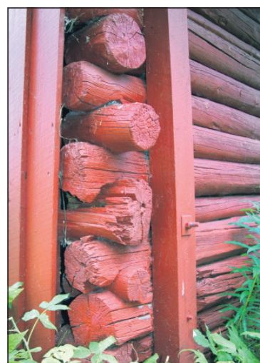
BJELKE: På noen av husene er det skrudd fast bjelker slik at veggene ikke raser ut.
