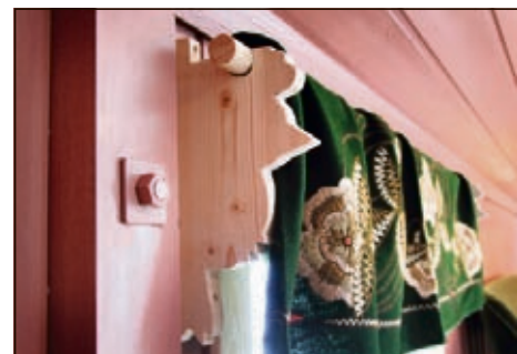
STREKKFISKER: I andre etasje er bjelker skrudd på plass for å stive opp huset. Gardinstengene har kreativt oppheng med egendesignet hønemotiv.
