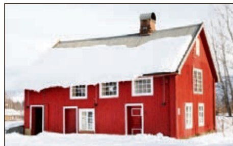
HUSMANNSTUA: Første etasje er opprinnelig fra 1780.
