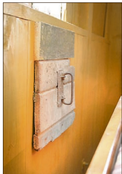
MØKKLUKA: I fjøset er møkkluke bevart. Med overnatting kan den være fin for lufting?
