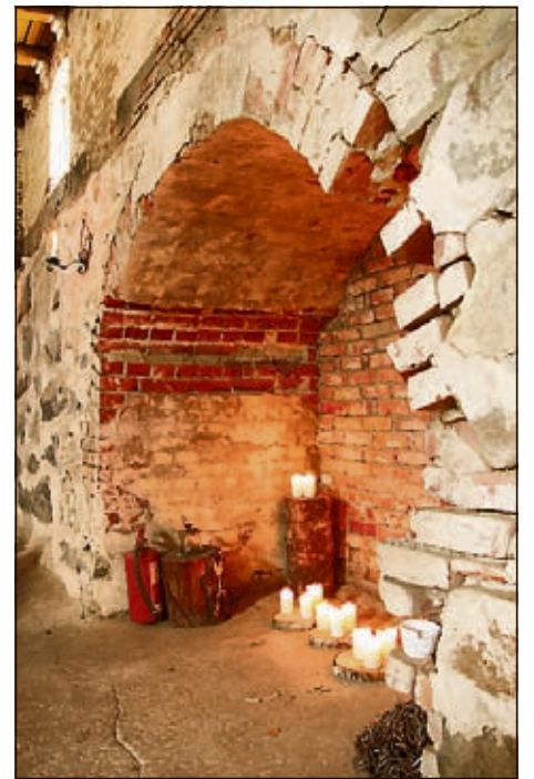
GAMMEL MUR: Murveggen er bevart slik den ble bygd.
