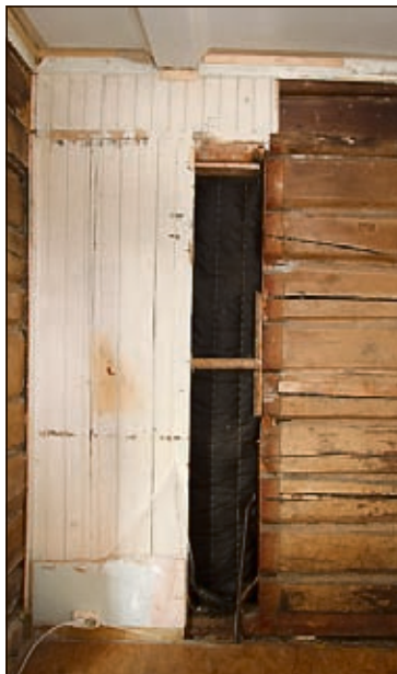
DØRÅPNING: Gammelt panel foran en ukjent døråpning kom til syne når de gamle huntonittplattene ble revet ned.
