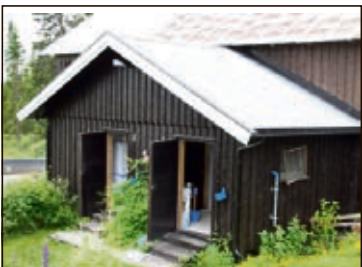
NYTT PÅBYGG: Moderne ystebu og mjølkerom skaper næringsgrunnlag for å bevare det gamle fjøset på Nøssvold.
