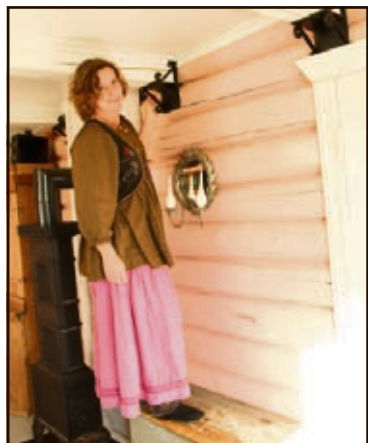
SMIDDE SKO: Elin fikk laget støttesko i smijern for å holde oppe de nye bærebjelkene i taket. En langt rimeligere løsning for å redde et tak som henger enn den tradisjonelle løsningen med å felle inn bjelkene.
