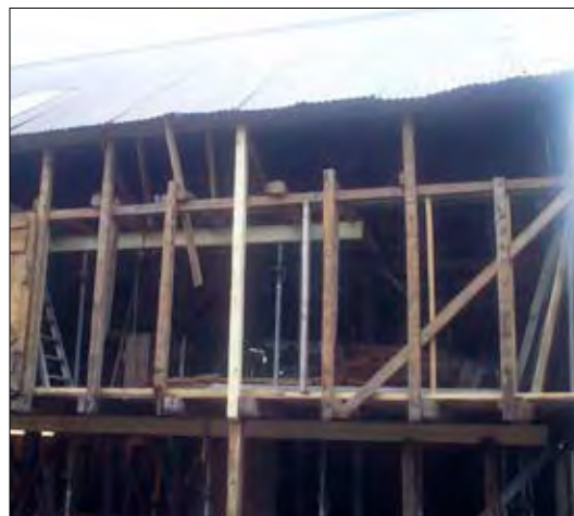
Arbeidet er i gang. Kun skadet virke skiftes ut. Foto: Haakon Aase.
