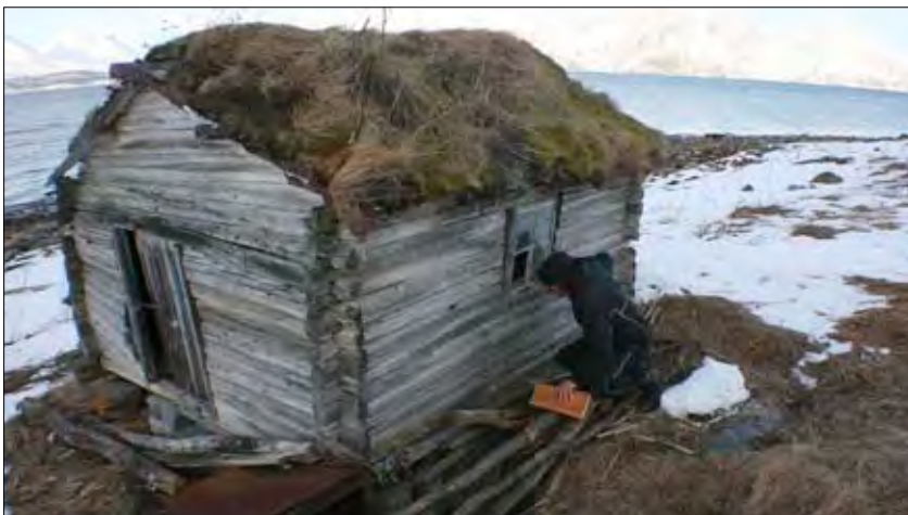
Ei sjøbu i forfall. Her før restaureringsarbeidet er påbegynt. Foto: Bjørn Langgård
