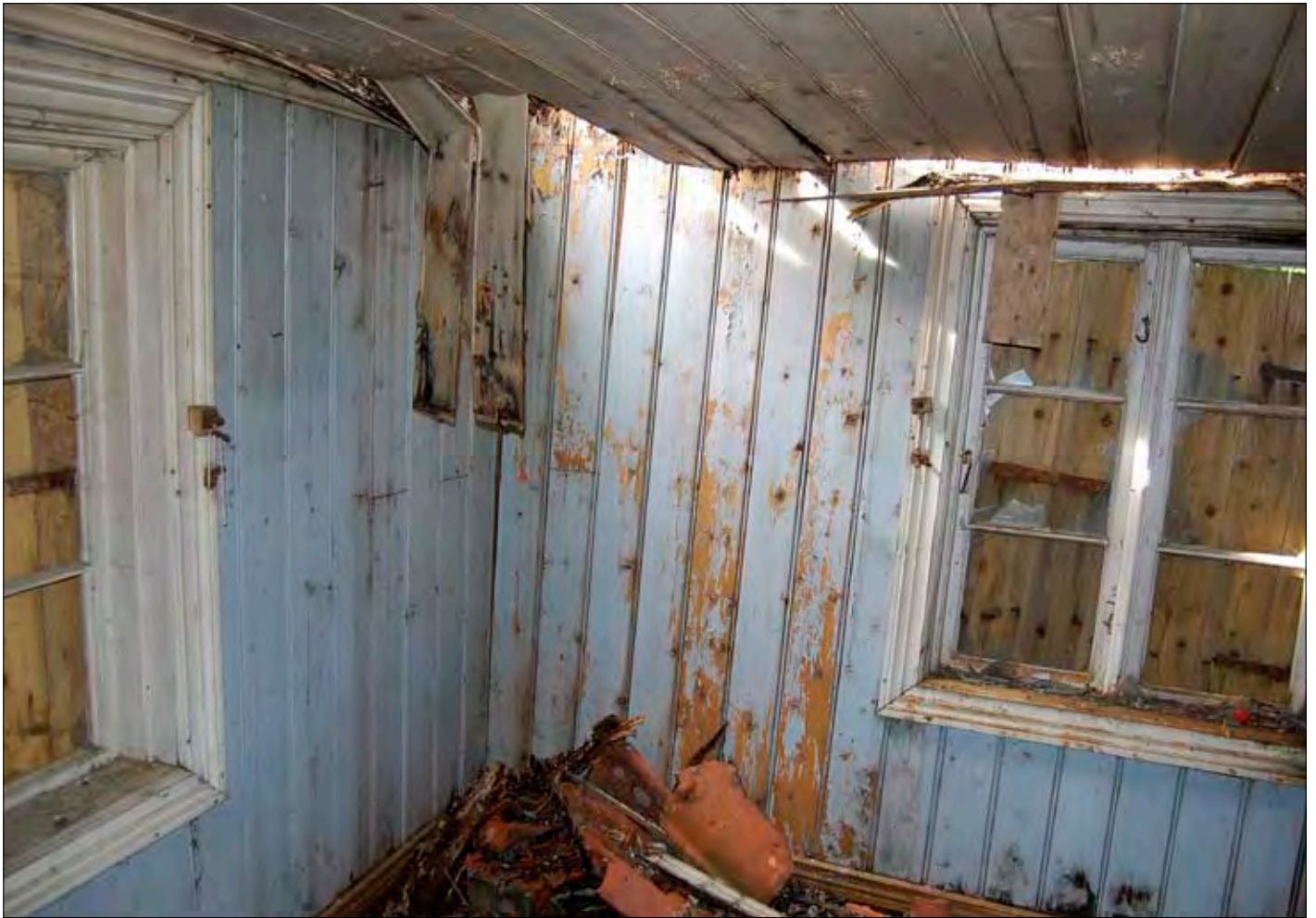
Huset var også svært råteskadet innvendig. Foto: Einar Engen, Kulturminnefondet.
