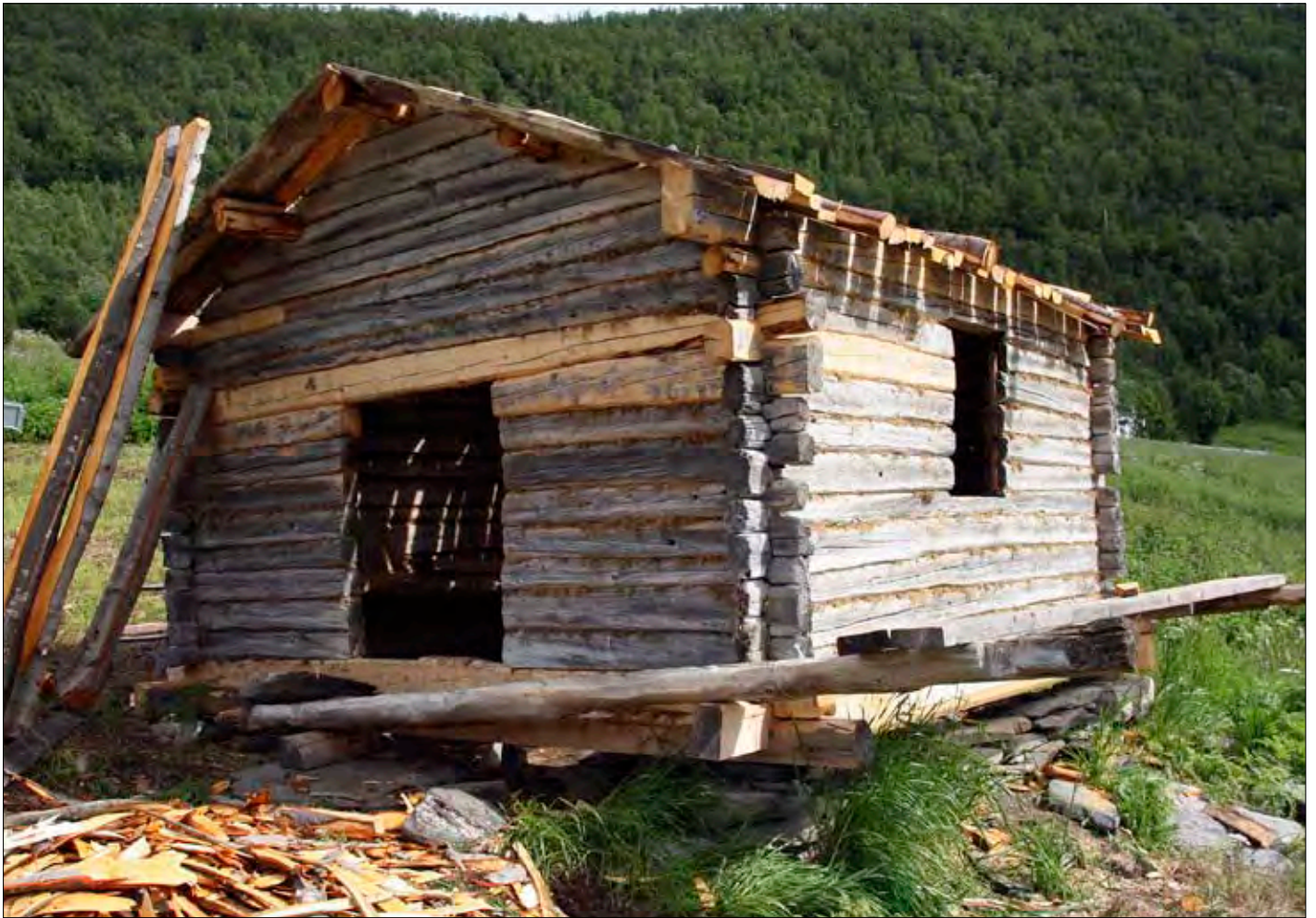
Under restaurering. Foto: Bjørn Langgård
