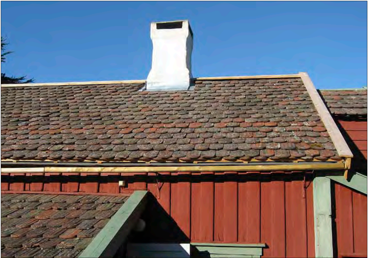
Nytt tak er på plass. Bildene viser framsiden av huset. Foto: Erik Jondell.
