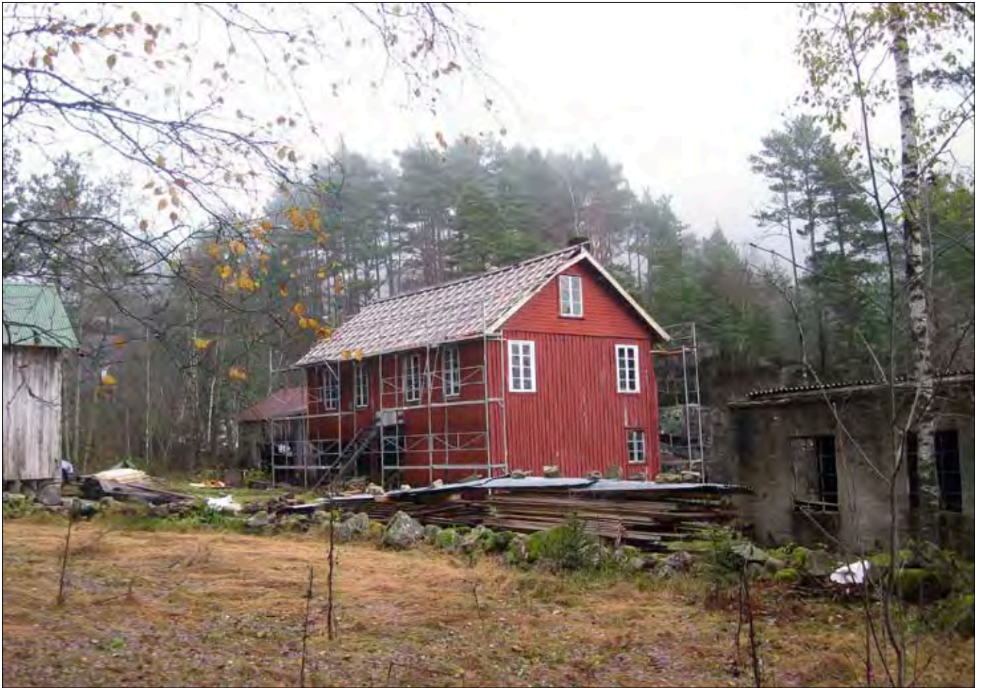
Fabrikkbygningen får nytt tak. Foto: E. A. Tesaker.
