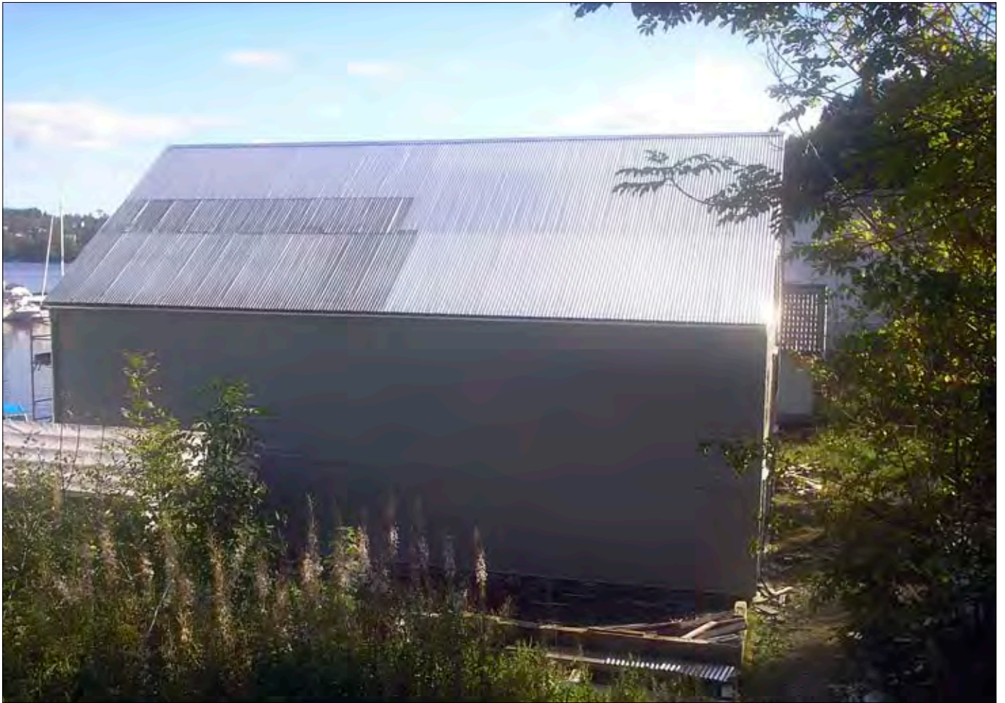
Nordveggen er ferdig malt med opprinnelig malingstype, linolje, og farge. Åpninger for vindu er ennå ikke utskjært. Foto: Haakon Aase.
