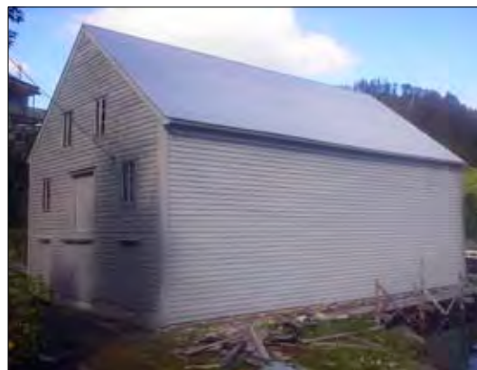
Veggene mot vest og sør. På vestgavlen er gamle dører gjeninnsatt, mens langsiden mangler utskjæringer for vinduer. Foto: Haakon Aase.
