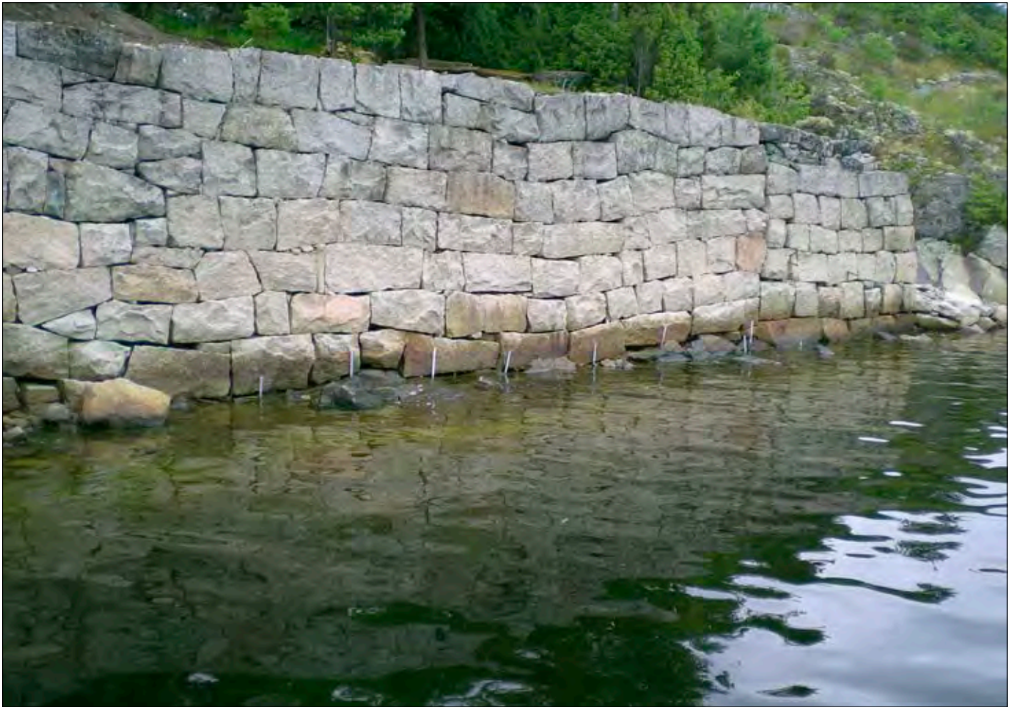
Nye jembolter på plass som sikring for blokkene langs vannkanten. Foto: Tor Einar Berger.
