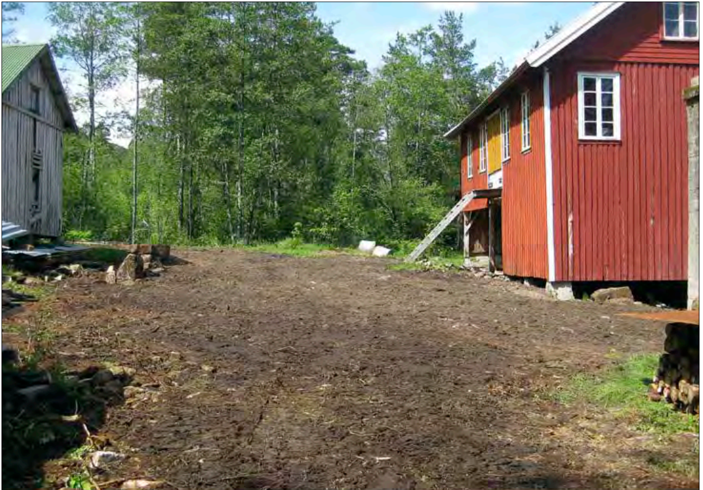
Området foran fabrikkbygningen ferdig planert. Foto: E. A. Tesaker.
