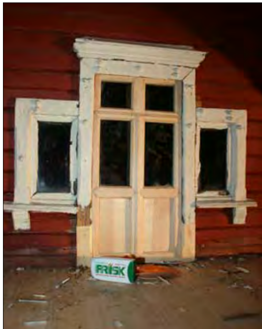
Bildet til høgre: Ein av verandadørene i andre etasje etter reparasjon. Frisk-eska illustrerer storleiken. Foto: Ola H. Fjeldheim, Ullensaker kommune.
