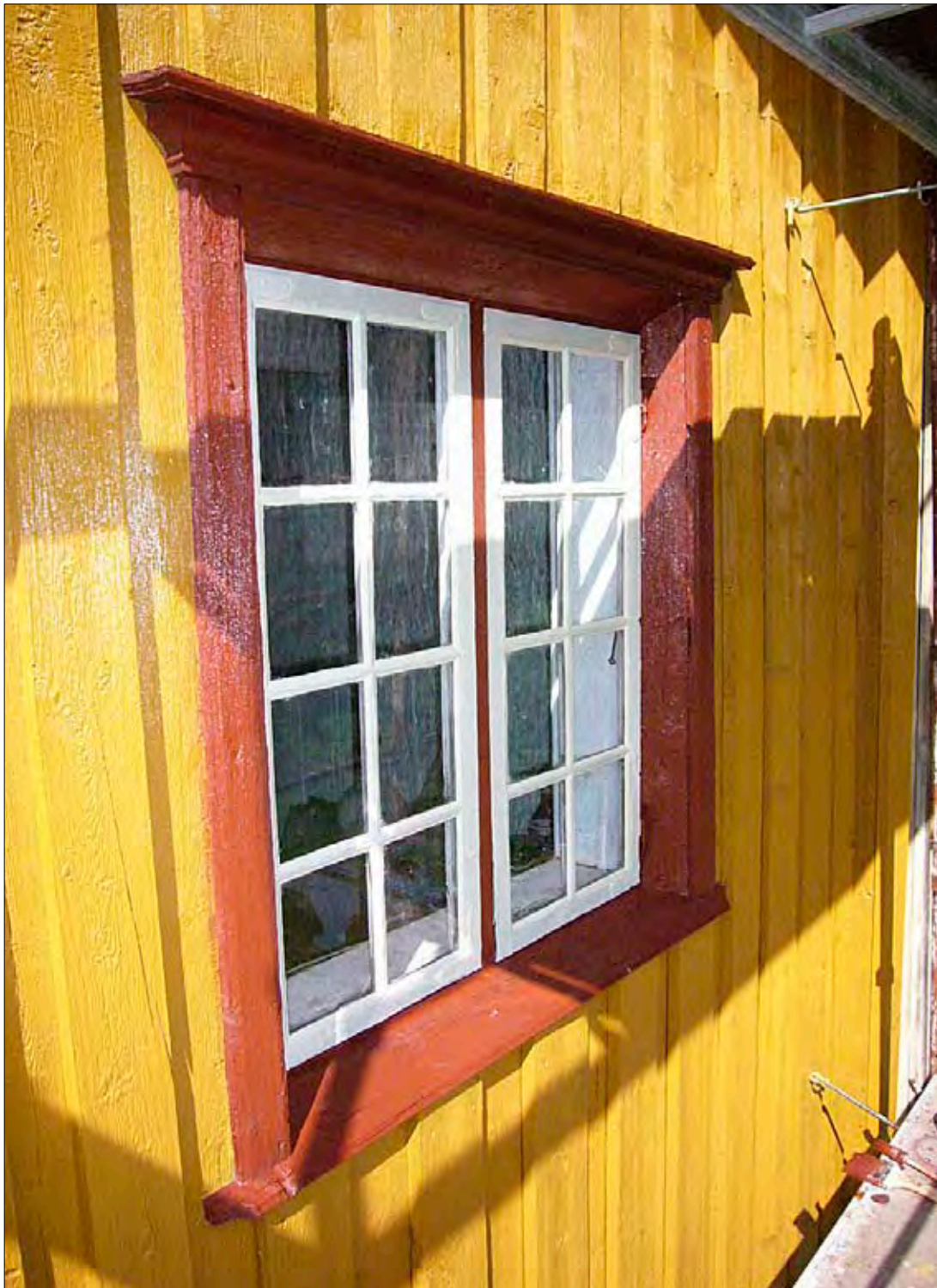
Ferdig istandsatt og malt vindu. Foto: Arnt Magne Haugen.
