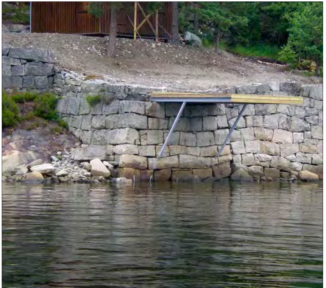
Granittkai etter istandsetting. Den «nye» landgangen er på plass med forankring i blokkrad nr. 2. Foto: Tor Einar Berger.
