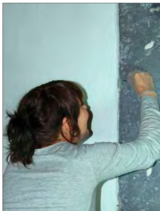
Til venstre: Mørtelreparasjoner. Skaden fuktes og mørtel legges i. På bildet: Maren Midtdal. Foto: Joanna Hench.
