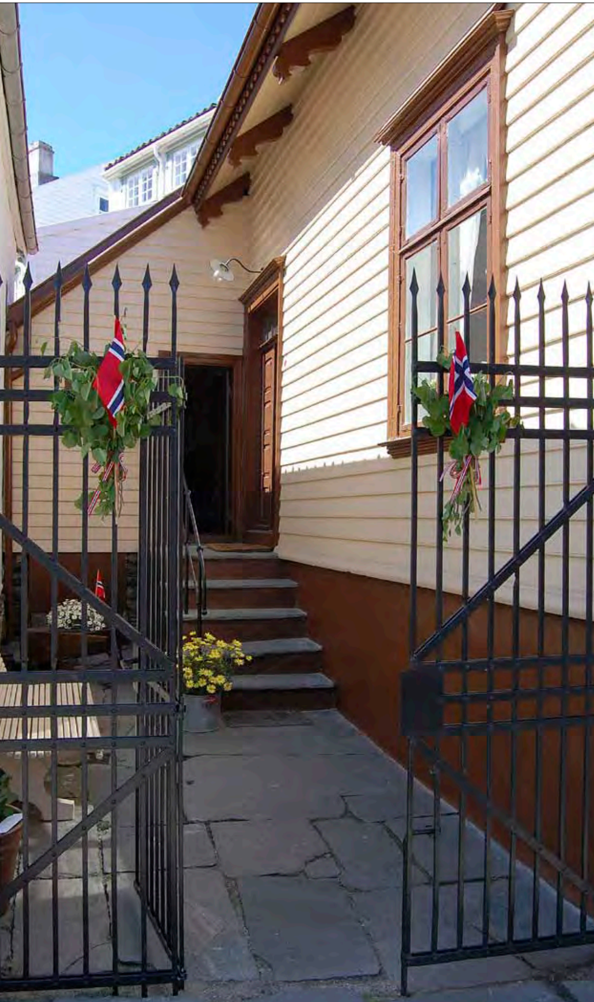
Port og inngangsparti etter istandsetting. Foto: Stavanger kommune, Hanne Windsholt.
