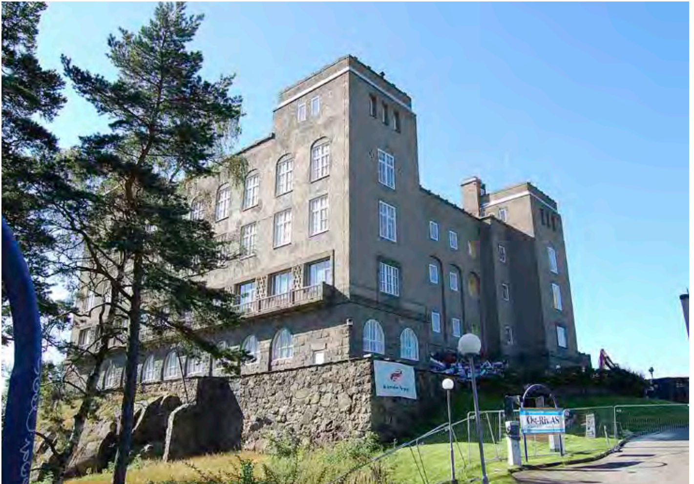
Sjømannsskolen av Bjercke og Eliassen, sett fra utsiden. Foto: Einar Engen, Kulturminnefondet.
