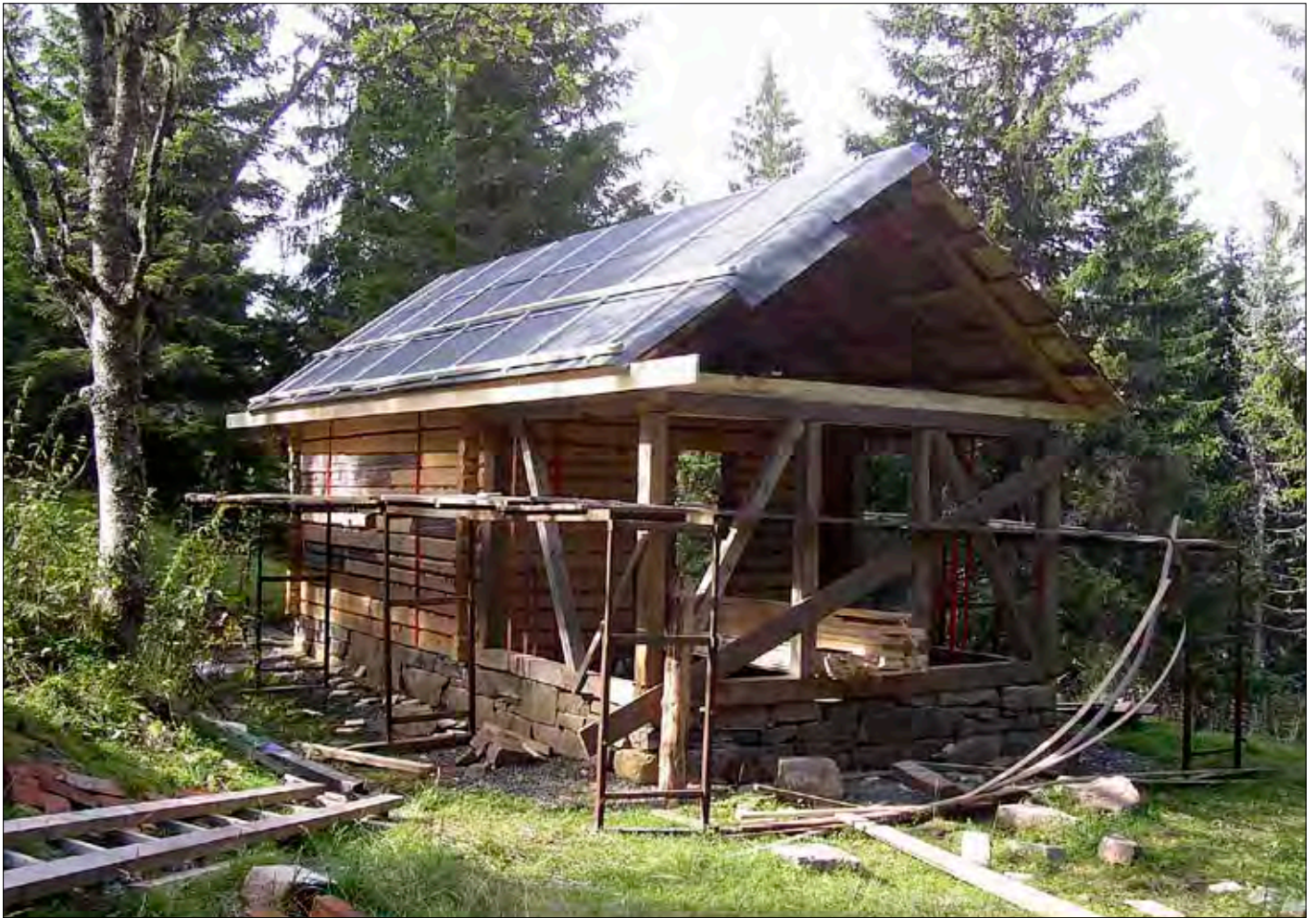
Laftekassa er oppe og bygningen begynner å ta form. Foto: Reidar Brennsæter.
