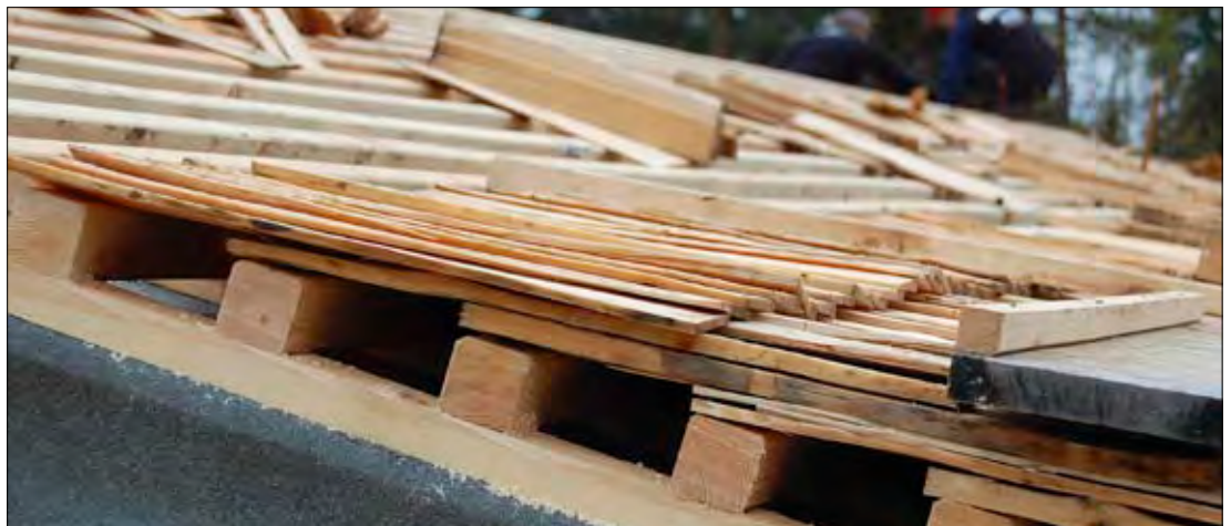
Snitt som viser hvor mange lag et stikketak har.
