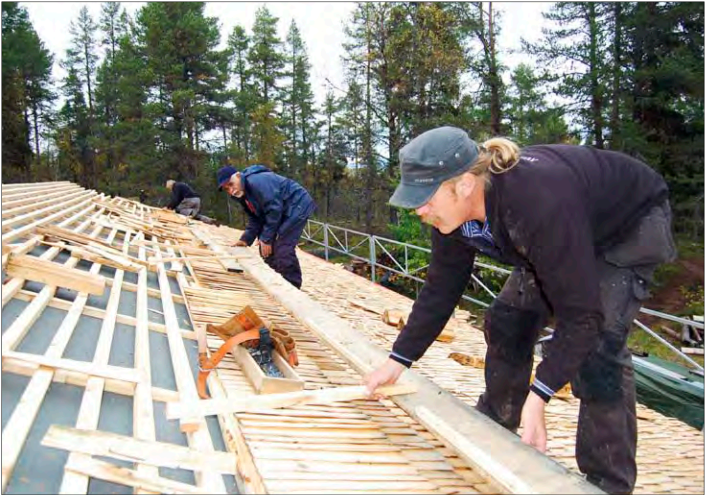
Foto: «Reia går». Anlegget flyttes opp slik at neste rekke kan festes.
