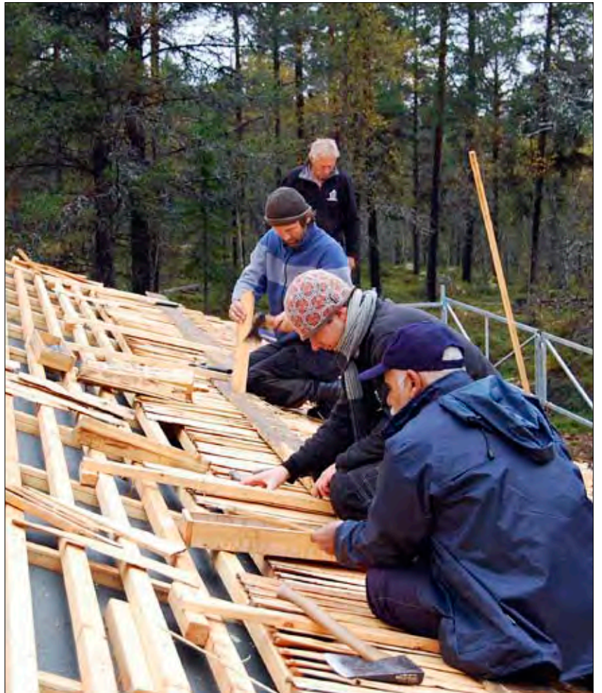
Bildene over: Stikken tilpasses med øks og spikres med 2,5" spiker. For å få en god arbeidsrytme jobber flere mot samme anlegg. Fotos: Einar Engen, Kulturminnefondet.
