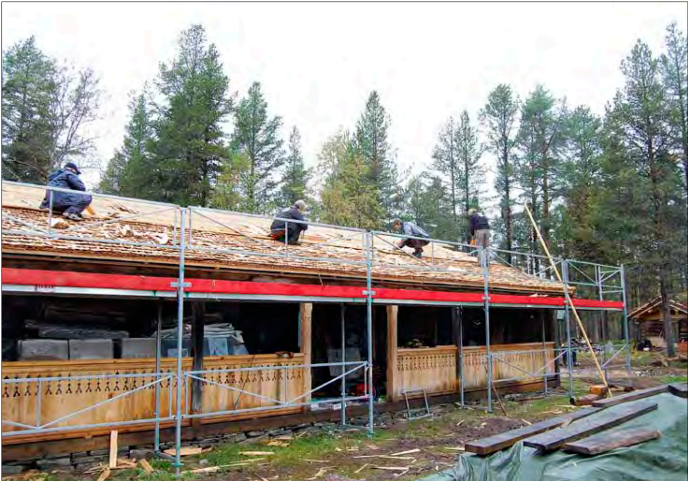
Mange mann i arbeid på taket under kurset i tekking. Foto: Einar Engen, Kulturminnefondet.
