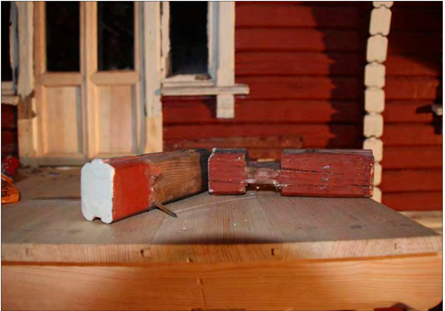
Bildet over: Skadde stokkar etter utskifting. Foto: Ola H. Fjeldheim, Ullensaker kommune.
