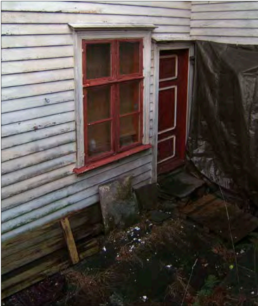
Vindu før istandsetting. Foto: Stavanger kommune, Hanne Windsholt.
