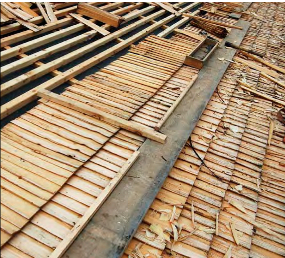
Bildene over: Stikken tilpasses med øks og spikres med 2,5" spiker. For å få en god arbeidsrytme jobber flere mot samme anlegg. Fotos: Einar Engen, Kulturminnefondet.
