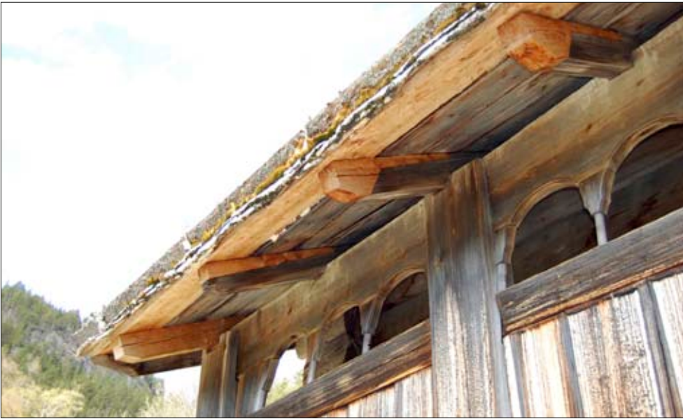
Rygnestadloftet i Valle i Aust-Agder er bygd på slutten av 1500-tallet. Under istandsettingsarbeidet ble det innspunnet friskt virke i taksperrene for å bevare mest mulig av opprinnelige bygningsmaterialer.
