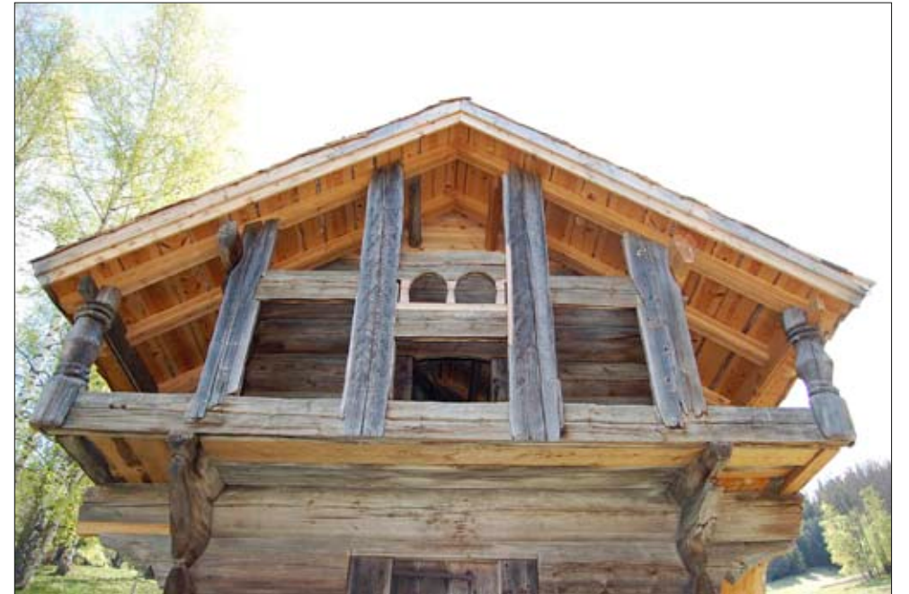
Under istandsetting ble råteskadet virke skiftet ut med tilsvarende materialkvalitet. Håndverker har valgt å skifte ut hele lengder og utført mindre grad av spunsing.
