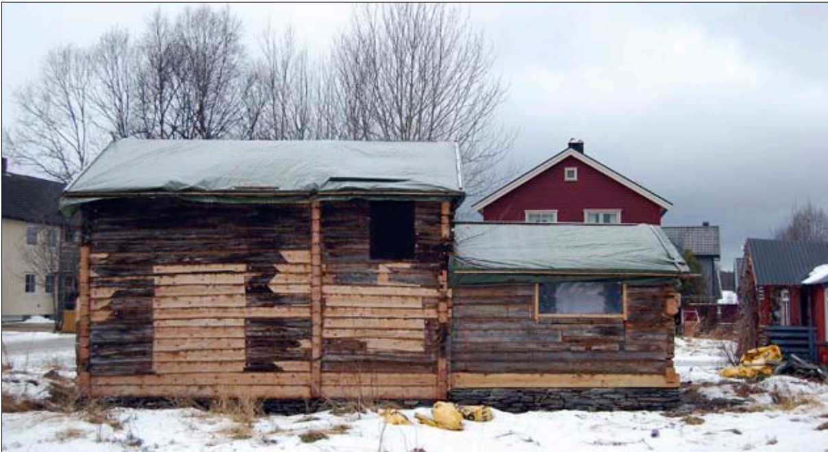
På Stormoen på Røros har Rørosmuseet og Røros kommune brukt et lite våningshus i forbindelse med opplæring av restaureringshåndverkere. Teknikken med innspunsing av virke er videreutviklet med tanke på å bevare mest mulig av opprinnelige bygningsmaterialer.
